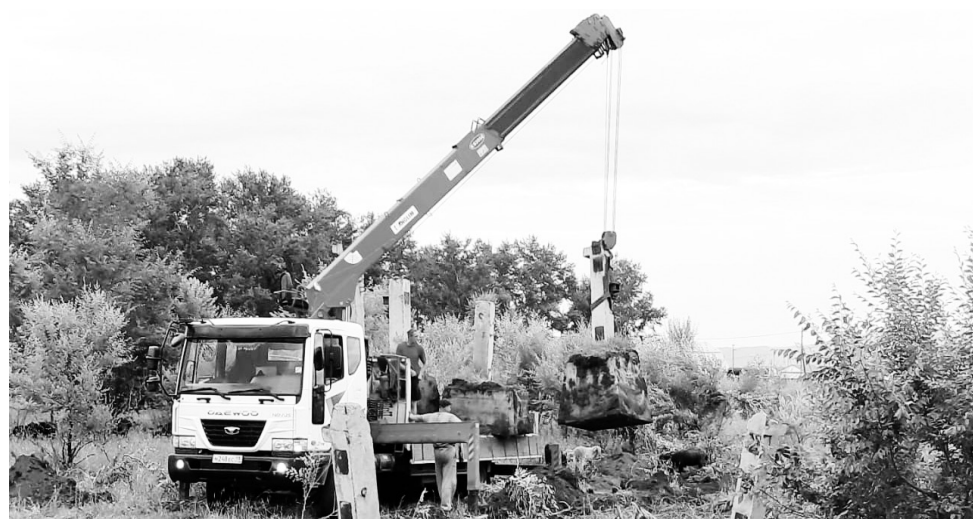
Подготовка площадки под строительство детсада в Новокурске
