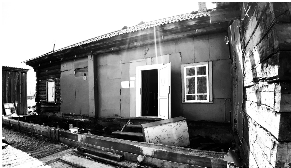
Будёновский детский сад на стадии ремонта
